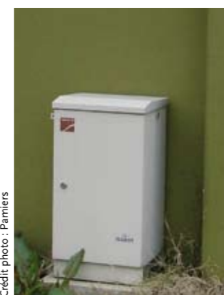
Coffret de régulation pour l'éclairage public.
